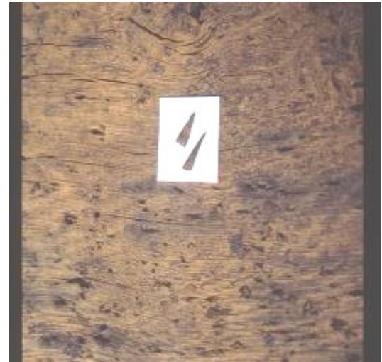
Område med mange nagler og huller efter nagler.
